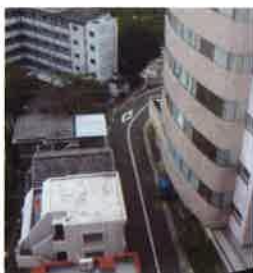
粘着剤劣化による像のくもり
